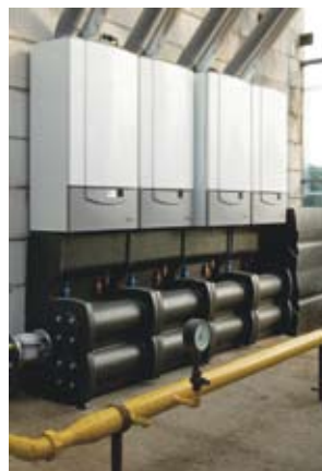
2. Aquinox OLB. Debiet van afgebeeld model: 1.230/10 min à 40°C
